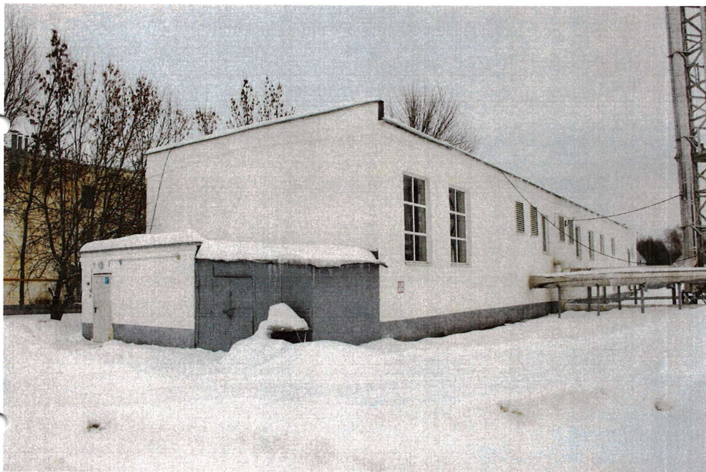
Фото – участок фасада здания
