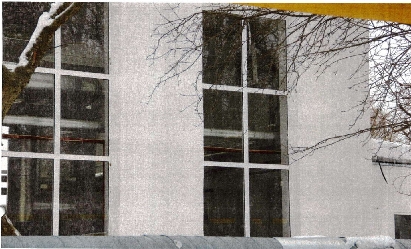
Фото – участок фасада здания
