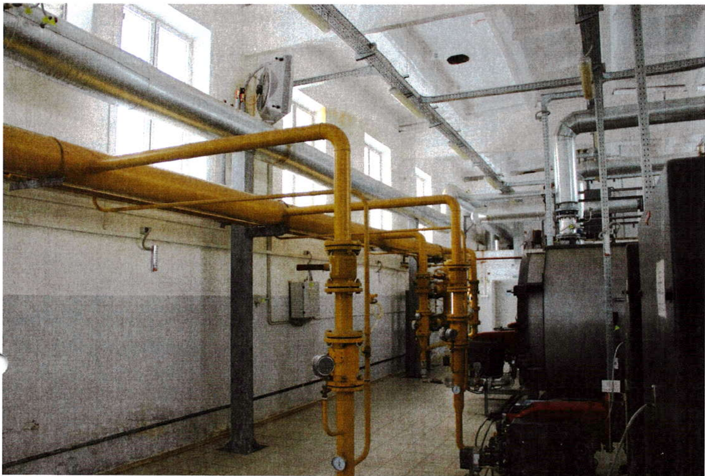
Фото – участок котельного зала
