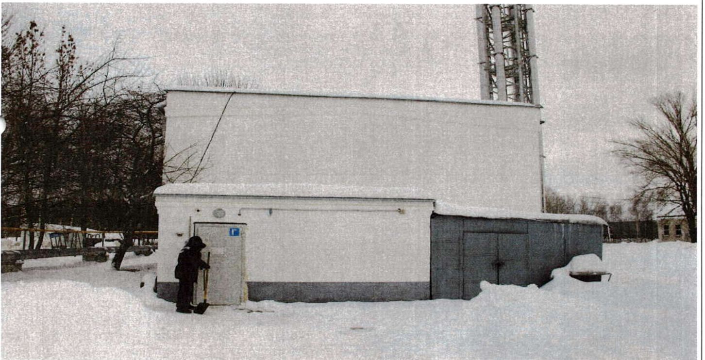
Фото – участок фасада здания
